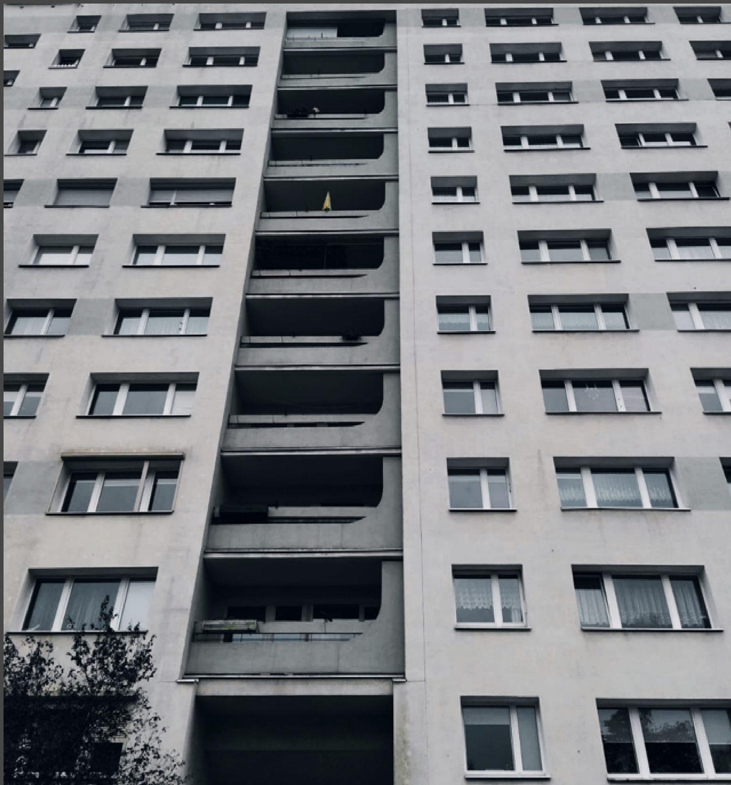
Jednostka mieszkaniowa osiedle Lecha, pod roboczą nazwą D Blok położony na os. Lecha 15-20 w Poznaniu (rozpoczęcie budowy 1974r. - zakończenie budowy 1976r.)
